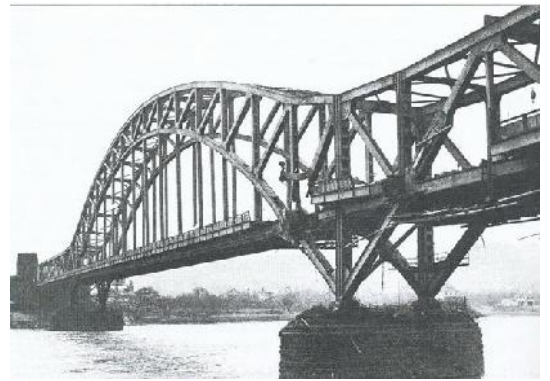
Dégâts causés par la tentative de démolition
